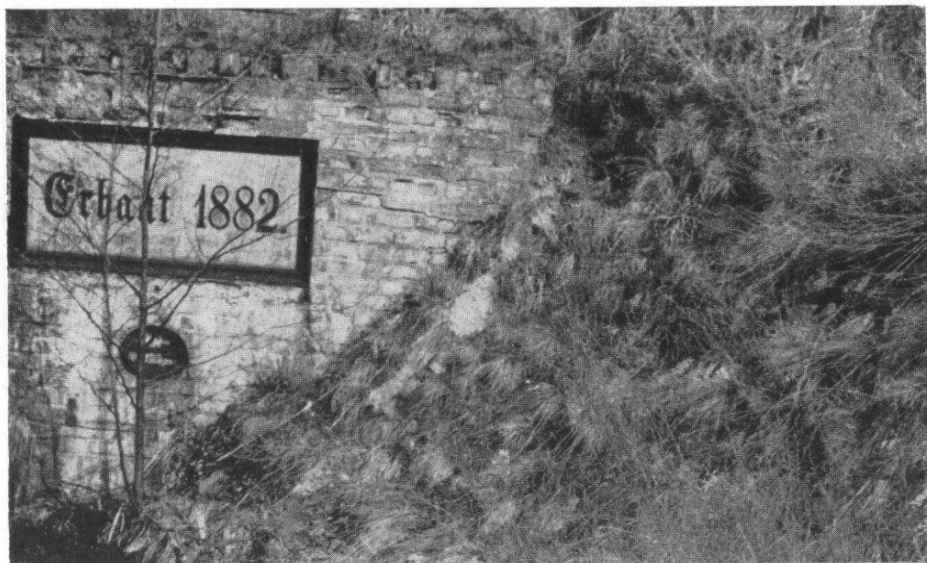
Abb. 6 Einschlipfstelle des Massenüberwinterungsquartiers von Ringel- und Glattnatter im Böschungsbereich der Schleuse Bischofswerda (Krs. Oranienburg) Foto: D. Knuth
